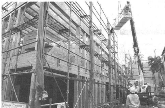
施工中の木造3階建て保育園
